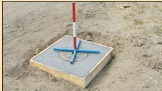
Új építés, köt a beton
